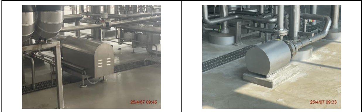
รูปที่ 16 การติดตั้งการ์ดป้องกันอันตราย
