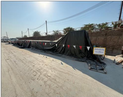
รูปที่ 5 การปิดคลุมกองวัสดุก่อสร้าง
