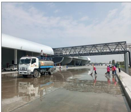
รูปที่ 6 การฉีดพรมน้ำในพื้นที่ก่อสร้าง
